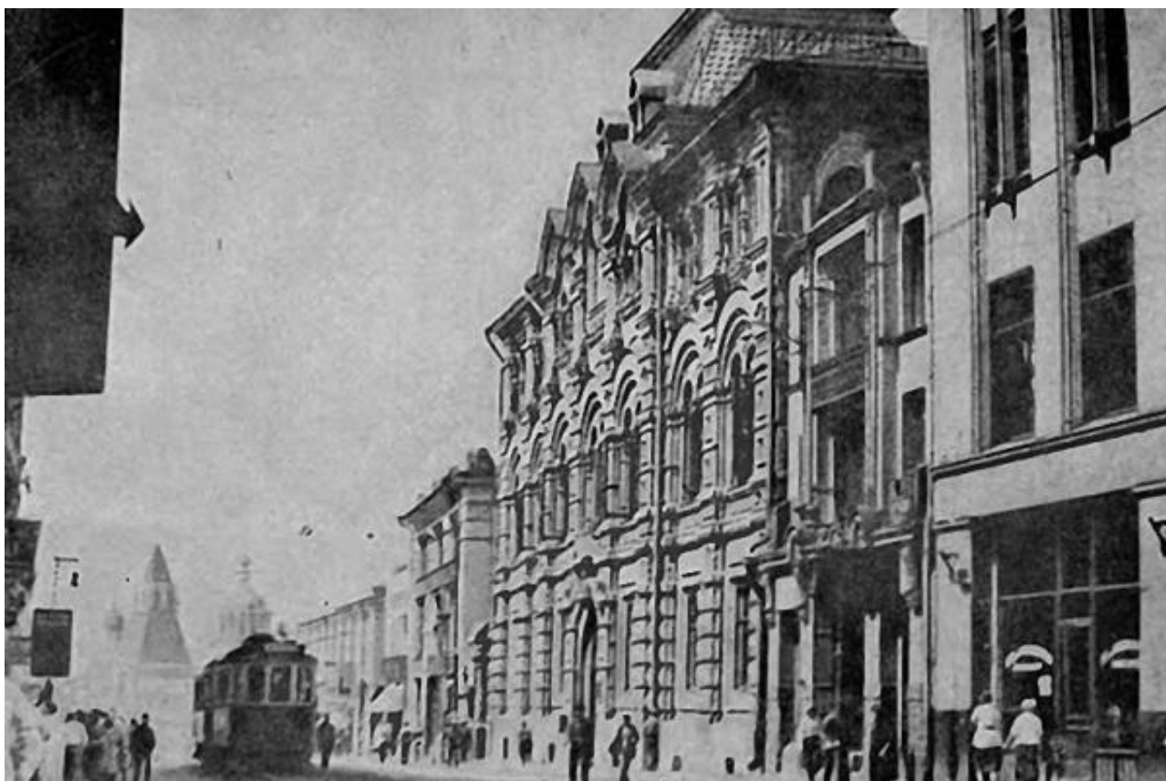
Здание научно-технического отдела ВСНХ. Москва, ул. Мясницкая (ныне дом 3). 1925–1926 гг.
